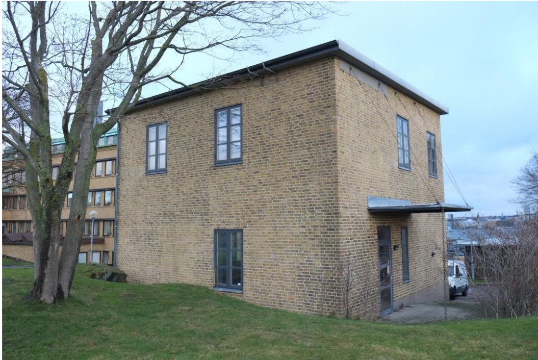
Figur 24 Gasverkets västra och södra fasad. På södra fasaden finns entré med plåtklätt skärmtak upphängt med vajrar från takfot. Foto från kulturmiljöutredningen.
