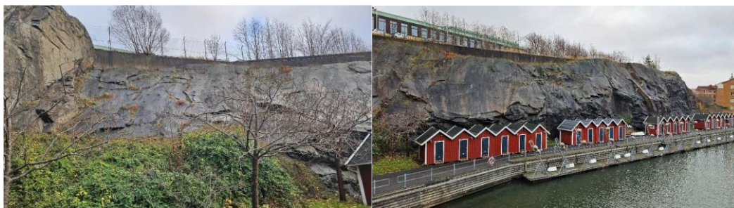
Figur 43 delområde västra bergssidan. Bild till vänster: bergskant med betongstöd mur längs släntrön väster om Brasilia. Bild till höger: bergskant samt stödmur och contrefor.
