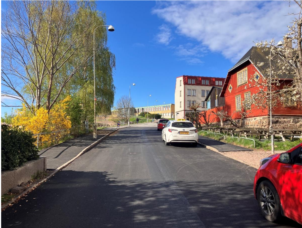
Figur 29 visar Plejadgatans utformning med trottoar på ena sida som söder om korsningen Plejadgatan och Lindholmsvägen övergår till trottoar om båda sidor. Till vänster i bild syns en gångtrappa som leder till Kunskapsgatan och vidare till Utvecklingsgatan.
