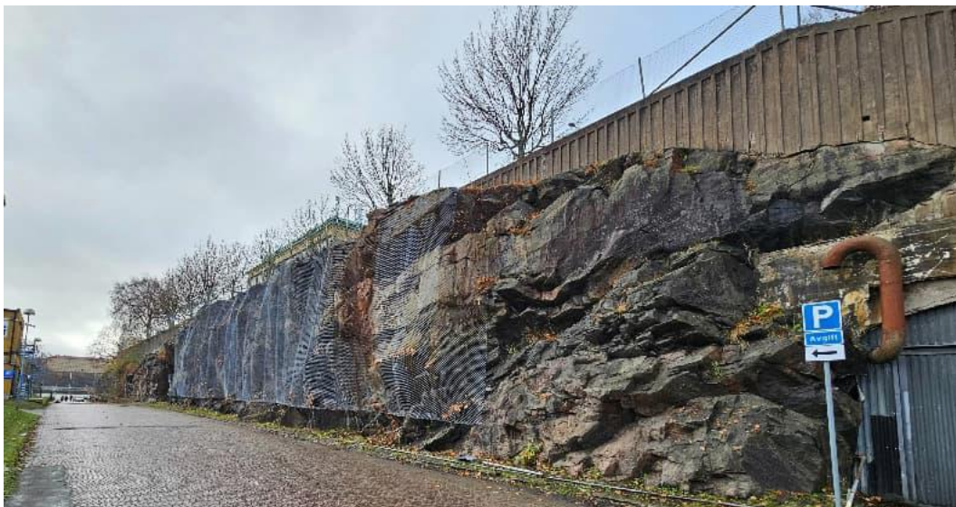
Figur 46 delområde östra bergssidan. Bergskant och stödmur utmed Kunskapsgatan.
